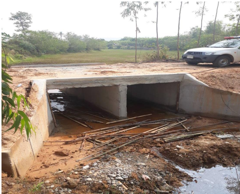
14. ก่อสร้างท่อลอดเหลี่ยมผายใหญ่ หมู่ 4
