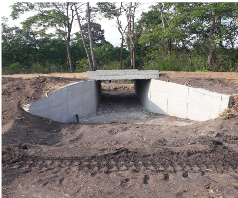
12. ก่อสร้างท่อลอดเหลี่ยมสายถ้ำหมอบ หมู่ที่ 2
