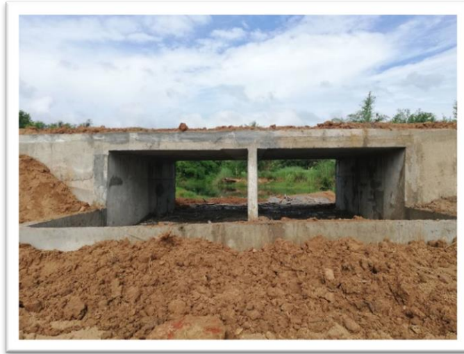
15. ก่อสร้างท่อลอดเหลี่ยมห้วยทราย หมู่ที่ 4
